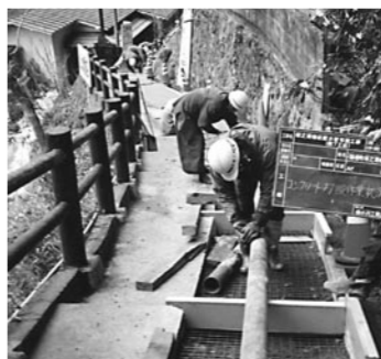
水道整備の様子
