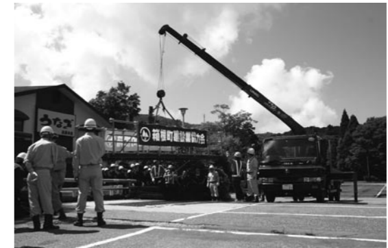
明神川が崩壊したとの想定で、仮設歩道橋を設置
