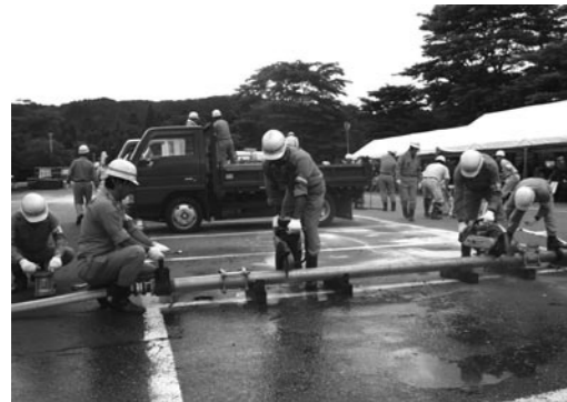
破損した水道管を切断・補修し、水道を供給
