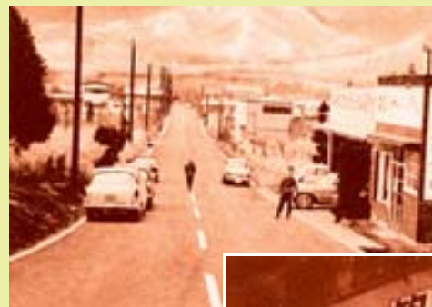
仙石原161号線道路 舗装新設(昭39)
