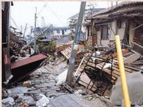
阪神淡路大震災で倒壊した家屋
