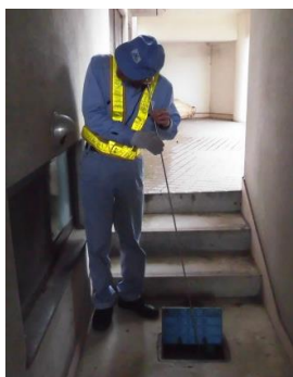
水道メーター付近漏水調査
