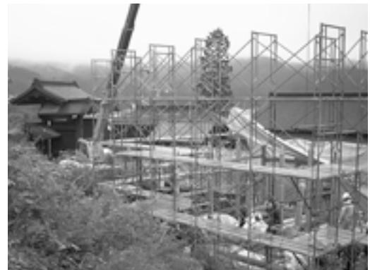
復元工事が進む足軽番所
