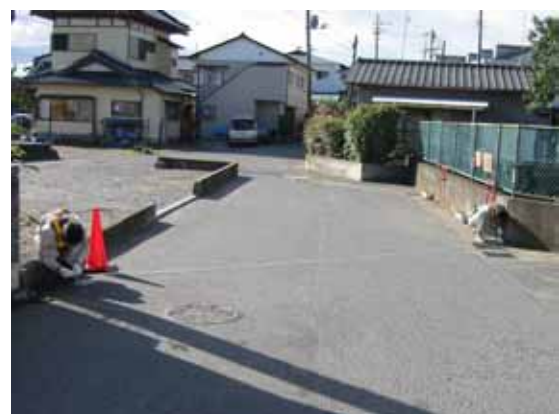
水平距離の測定(基準点～引照点)
