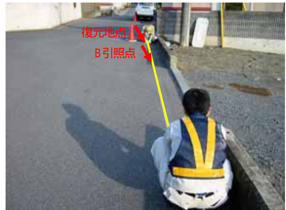
水系を張る(A引照点～B引照点～復元地点)
