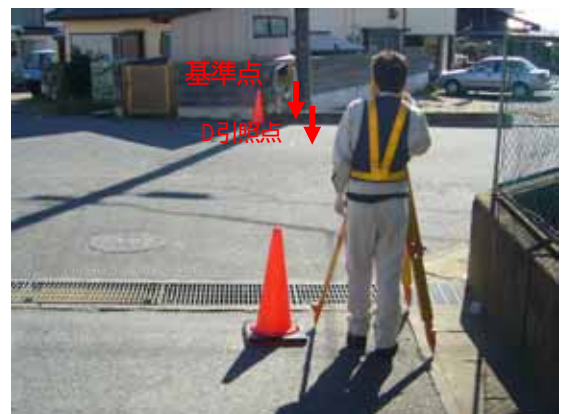
基準点埋設後の点検
