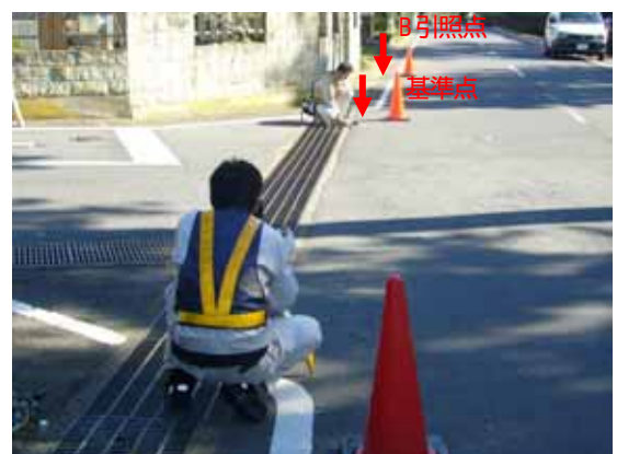
基準点埋設後の点検
