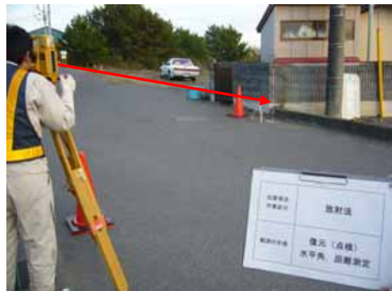
基準点埋設後の点検
