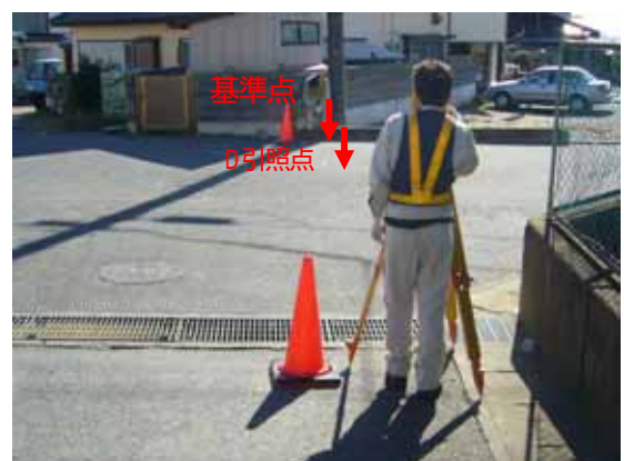
基準点埋設後の点検
