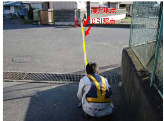
水系を張る(C引照点～D引照点～復元地点)
