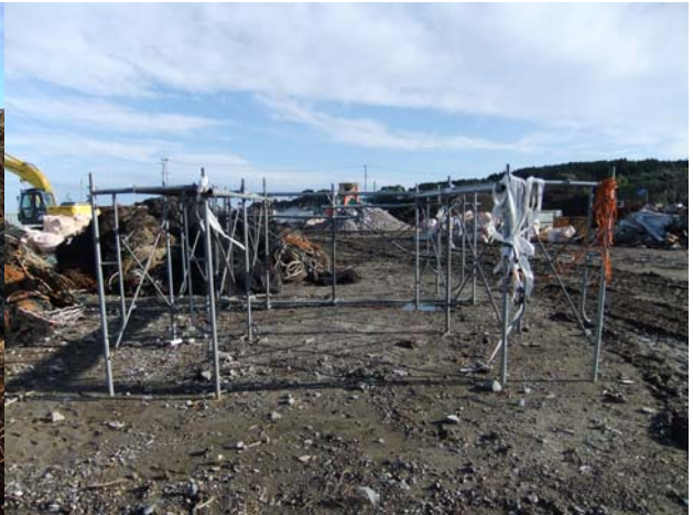
フレコン充填用の足場
