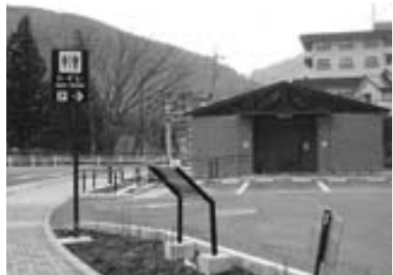
公衆トイレ (小涌谷)
