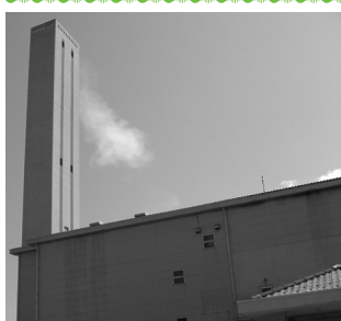
ごみ焼却施設(環境センター)
