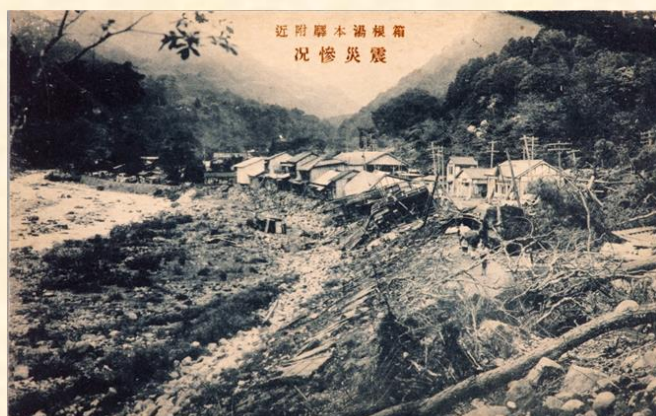
箱根湯本駅付近震災惨況
