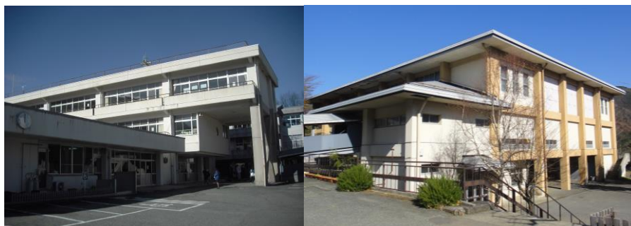
箱根中学校（校舎・体育館）
