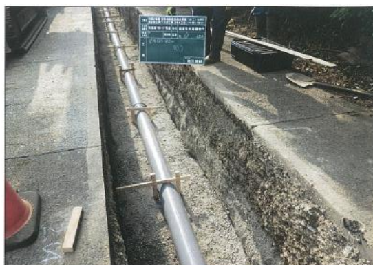
第2号公共下水道工事(284工区) 施工中
