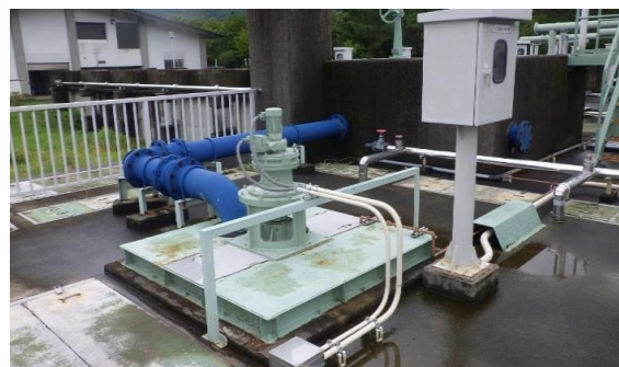
仙石原浄水センター機械設備整備工事完成
