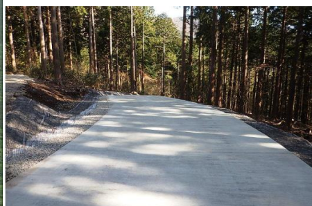
2号えん堤工事用道路
