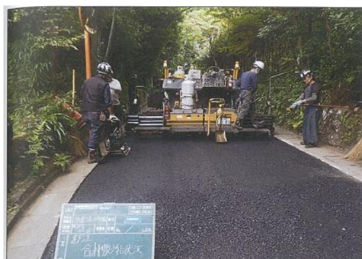
第1号公共下水道工事(路面復旧) 施工中
