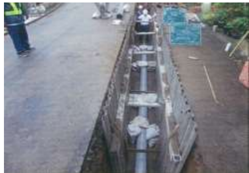
第1号公共下水道工事(第192工区)施工中写真
