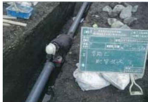
第2号公共下水道工事(第283工区)施工中写真
