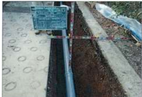
第1号公共下水道工事(第191工区)施工中写真
