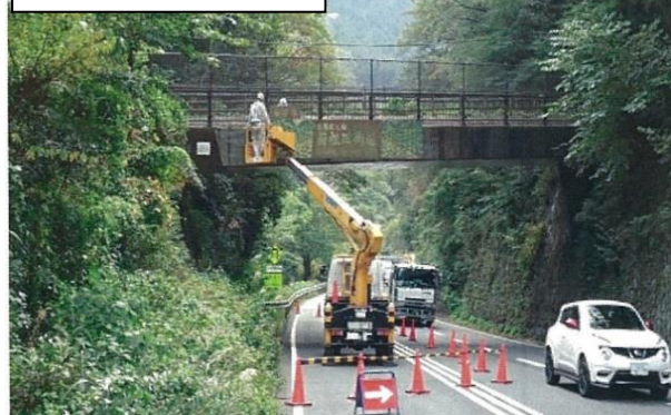
石畳橋の橋梁点検
