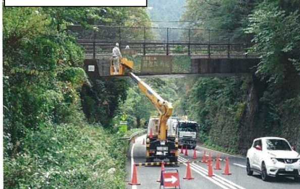
石畳橋の橋梁点検
