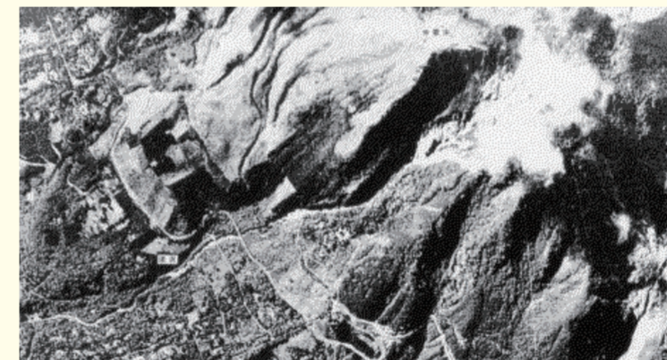
災害発生前の須沢
