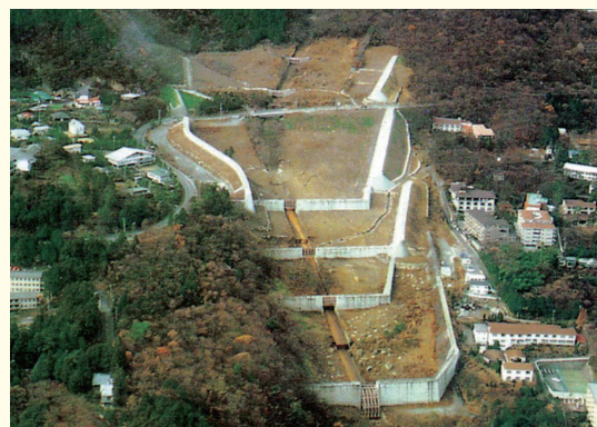
須沢砂防堰堤群
