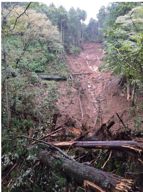
令和元年東日本台風による土砂崩れ
