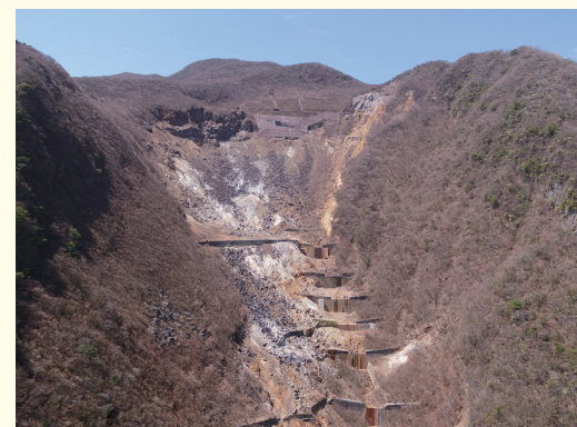
早雲山地すべり対策工事状況写真
