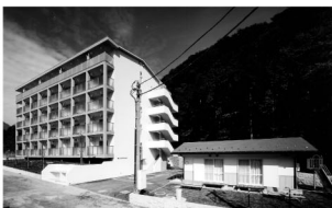
第2上河原町営住宅
