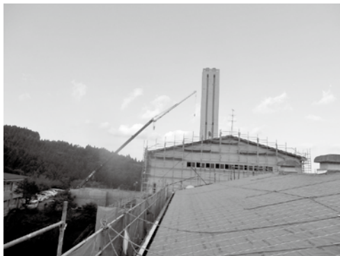
工事中の環境センター
