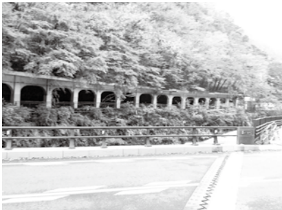
函嶺洞門バイパス
