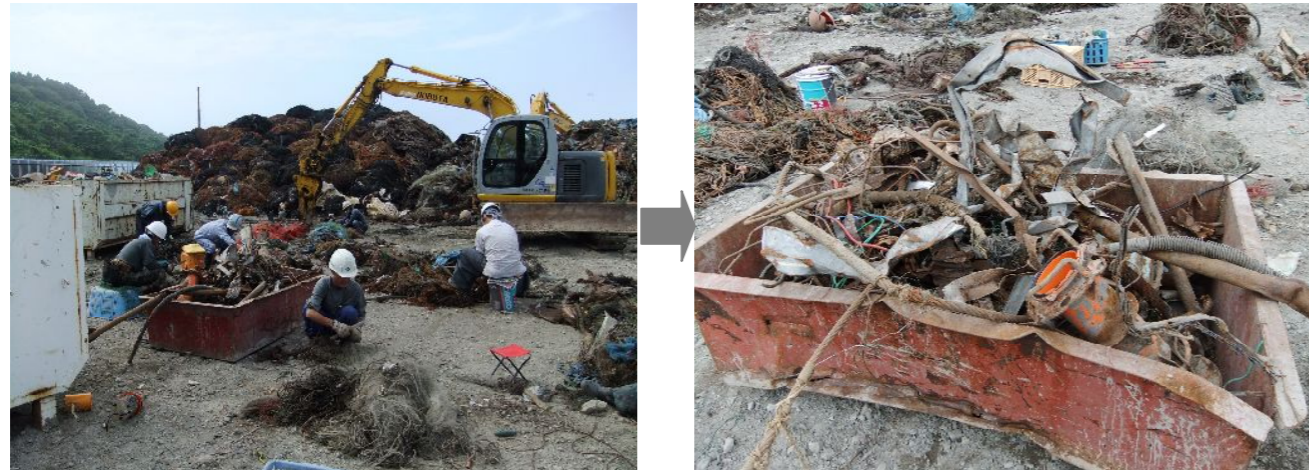
手作業による異物等の除去
