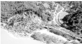
崩落により寸断された県道(長岡市)
