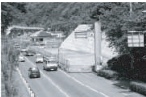
工事中の小田原箱根道路
