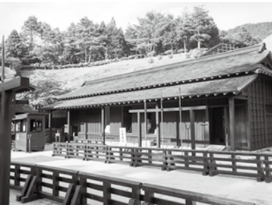
①復元施設再整備工事（箱根関所） ②上野工務店 ③8,675万7,000円
