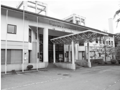
①仙石原公民館エレベーター設置 工事 ②勝俣工務店 ③6,413万円
