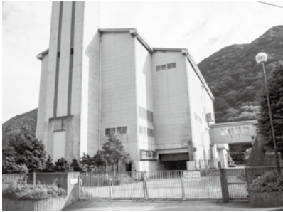
①粗大ごみ処理施設基幹的設備 改修工事 ②神鋼環境ソリューション 東京支社 ③2億8,820万円
