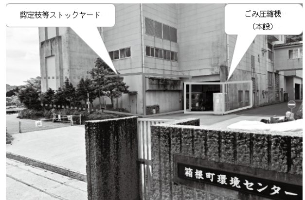
剪定枝等ストックヤードの設置場所
