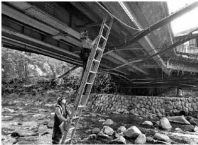
弥栄橋を点検中！
