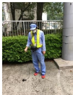
夜間水道管路調査
