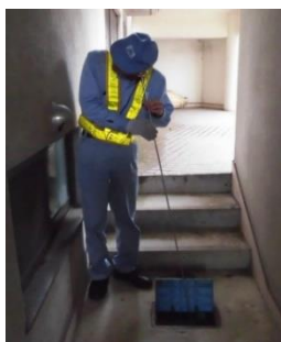
水道メーター付近漏水調査
