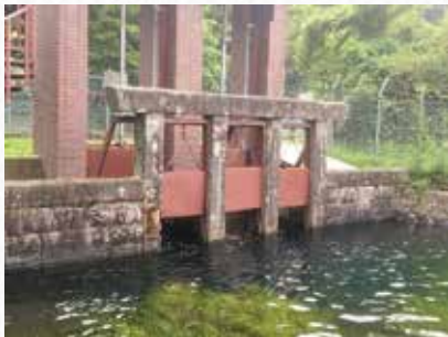
手前側は明治43年建造の水門 奥側は昭和62年建造水門
