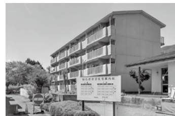
仙石原町営住宅CD棟
