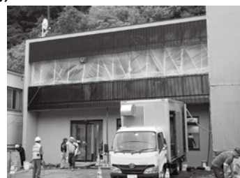
（仮称）温泉地域診療所建設工事
