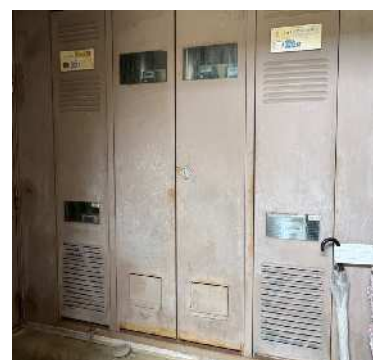
パイプシャフト扉
